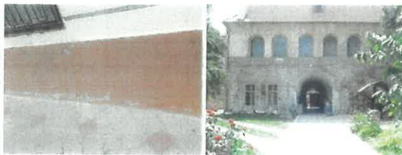
Foto nr. 13, 14 Umiditate ascensională, pe exterior
