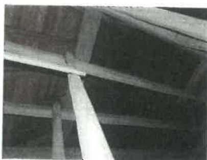
Foto nr.59 Intervenție inadecvată, consolidare coarda
