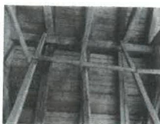
Foto nr 72 Suplimentarea inadecvată a corzilor laterale
